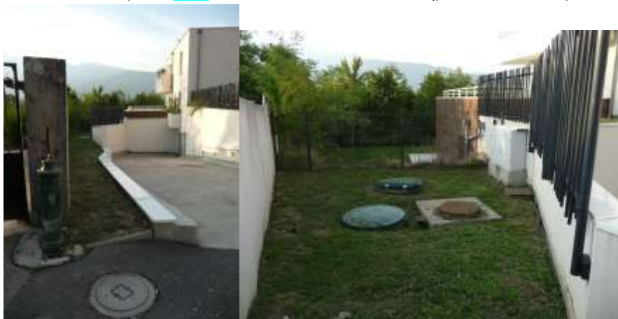
Zone de relevage des réseaux EU / EP
